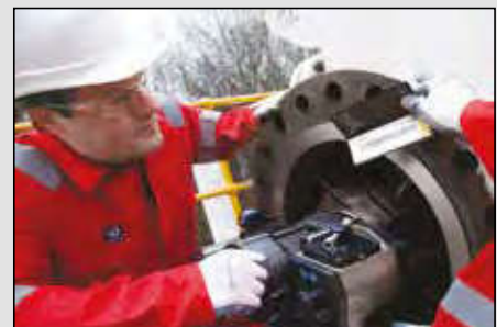
▲ Le macchine per la spianatura delle flange garantiscono l'integrità dei giunti flangiati.
