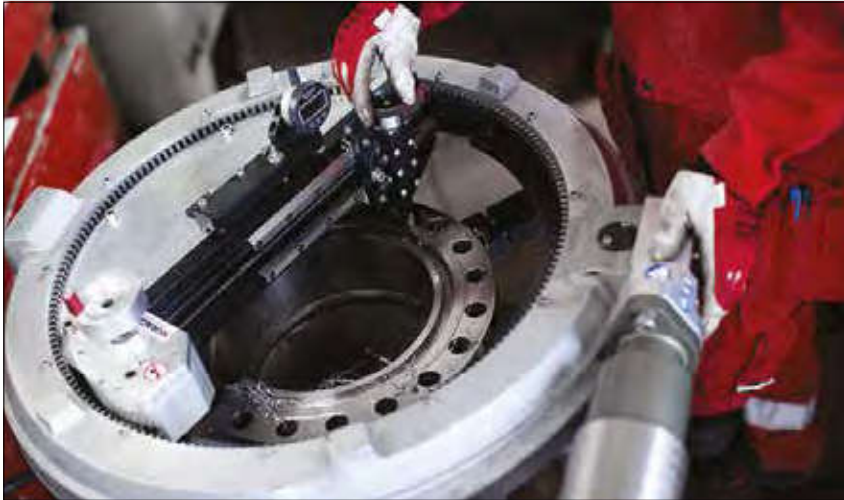
▲ Lavorazione di spianatura delle flange.
